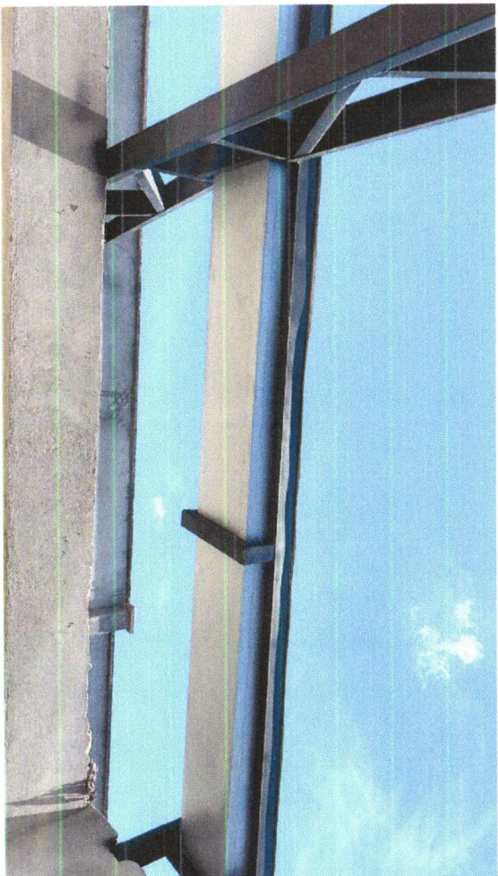
FOTO 107: INSTALAÇÃO CALHA PLUVIAL
